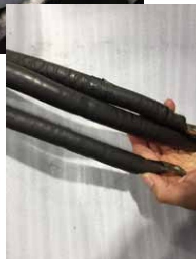
配線の汚れにも
